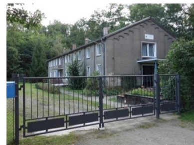
Außerhalb Sperrbereich, Vereinsheim, See- und Tauchsportclub Knappenrode e. V.
