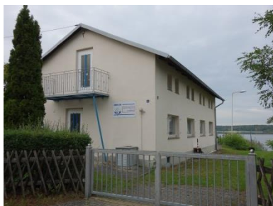
Im Sperrbereich, Vereinsheim, Bautzener Segelclub 1950 e. V.
