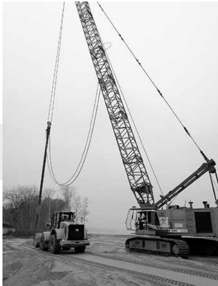
Geotechnische Sicherung am Koblenzer Graben
