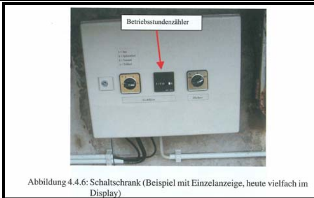
Abbildung 3 Schaltschrank einer KKA mit herkömmlichem Betriebsstundenzähler
