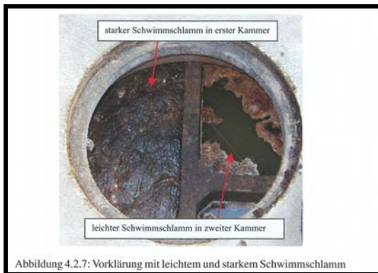
Abbildung 6 Schwimmschlamm Bildung in einer Kleinkläranlage
