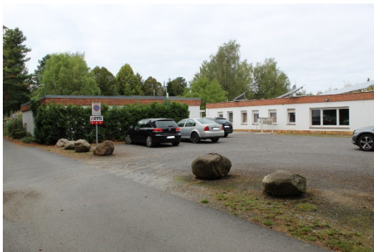
Zufahrt und Parkplatz der ETIG
